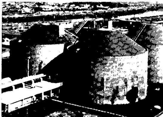
Foto 1 — Os digestores da ETE situam-se próximos à zona residencial do bairro de Pinheiros.
