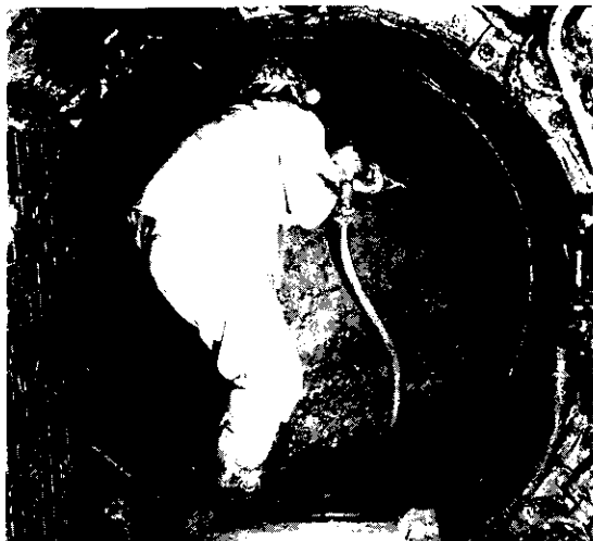
Foto 5 — Escavação manual no Mini Shield.
