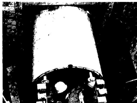
Foto 2 — O Mini Shield colocado no poço de serviço e iniciando a penetração.
