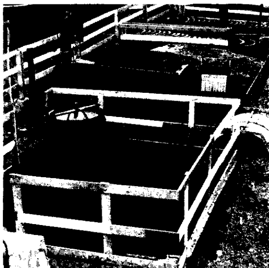
Foto 7 — Canteiro de serviço do Mini Shield.
