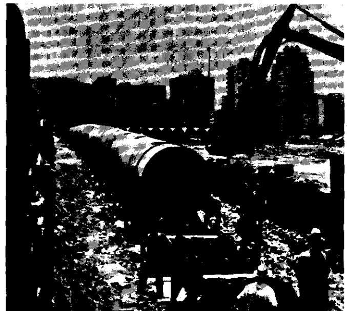
Transporte do 1.º string em terra.
