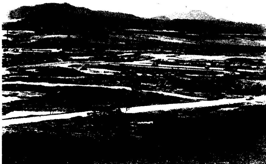
Ilustração 5 — Vista geral das obras de terraplenagem da ERO de Barueri.
