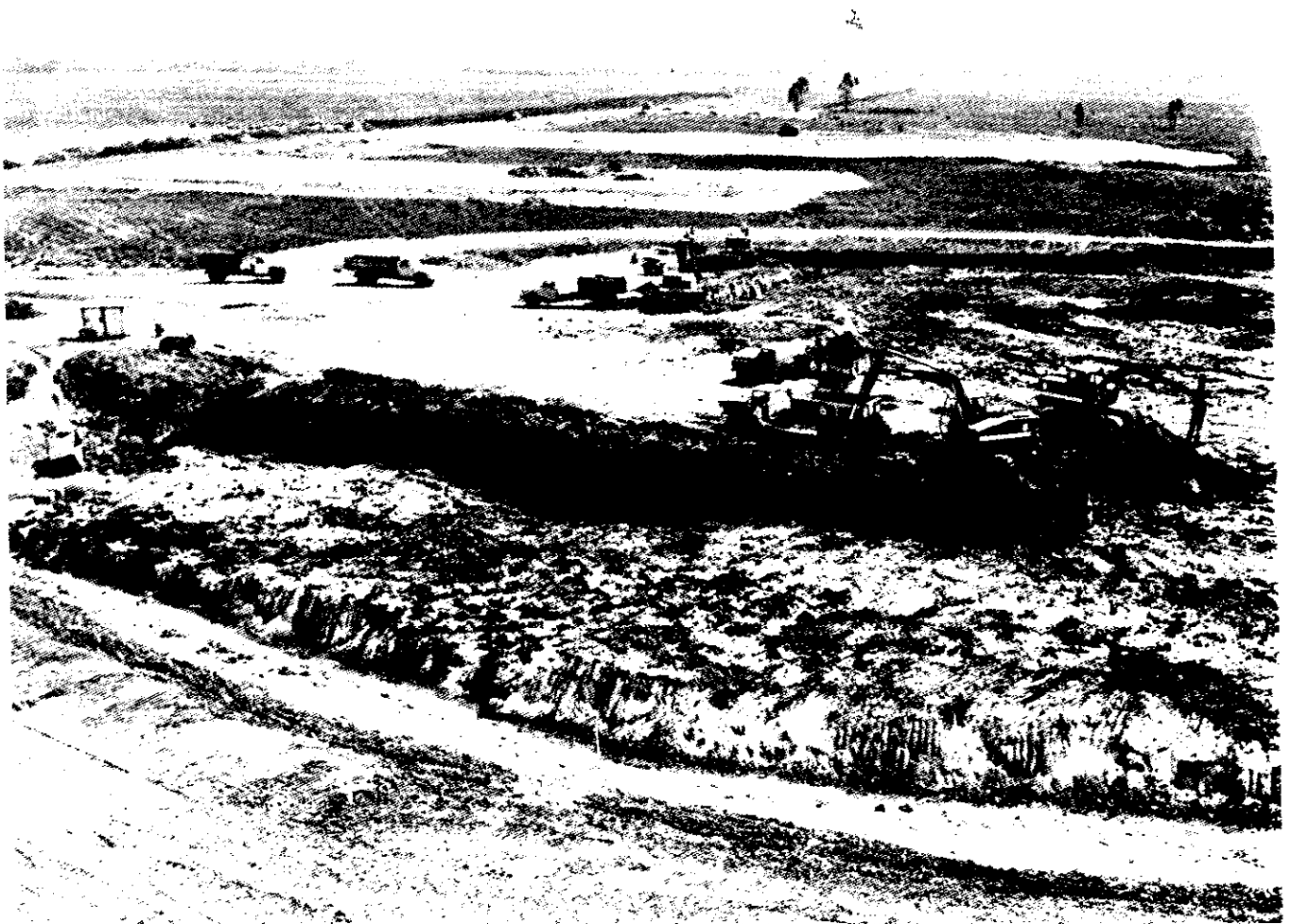
Ilustração 8 — Vista geral das obras de terraplenagem da ERQ de Suzano.
