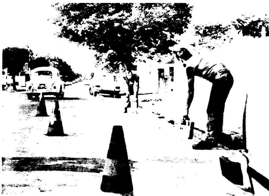
Ilustração 1 — Localizando um conduto de água por meio de um aparelho indutor receptor.
