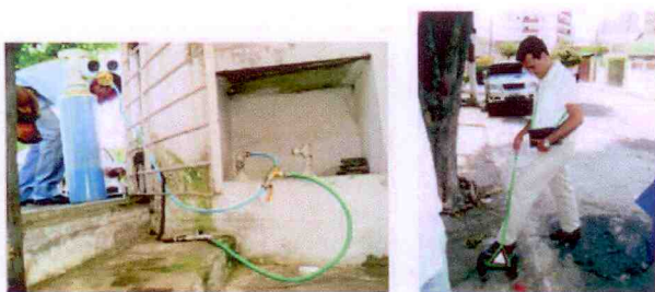
Figura 7 - Inserção e locação de vazamentos com a utilização de gás hidrógeno (Sabesp 2007).
