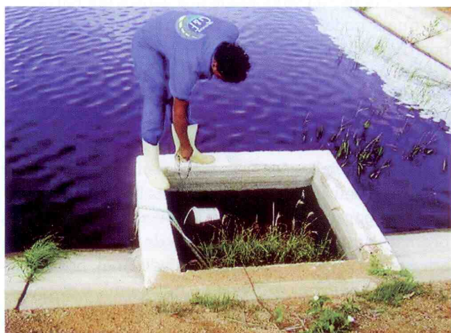
Figura 2: Coleta do lixiviado no vertedor da lagoa facultativa
