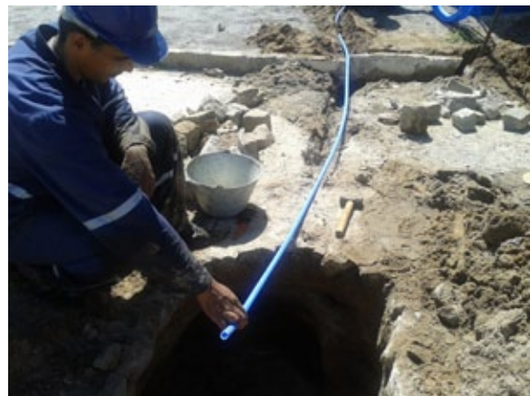
Figura 3 – Reparo dos vazamentos com a troca do ramal.
