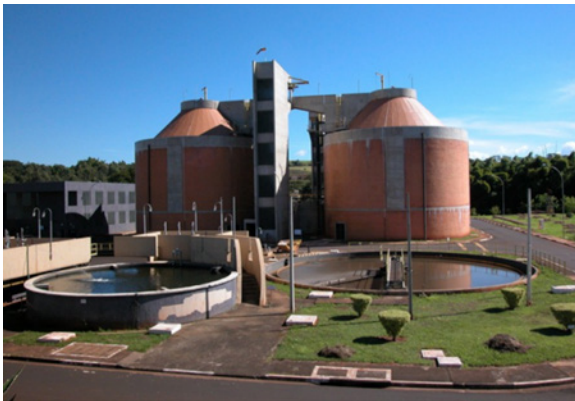
Figura 1: Digestores anaeróbios da ETE Franca – São Paulo sem sistema de aquecimento e temperatura média de 23°C
