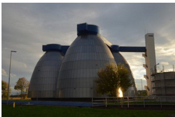
Figura 3: Digestores Anaeróbios de Lodo (37° C) da ETE Manheim - Alemanha
