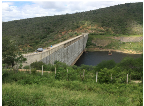
Figura 2 - Barragem de Jucazinho.
