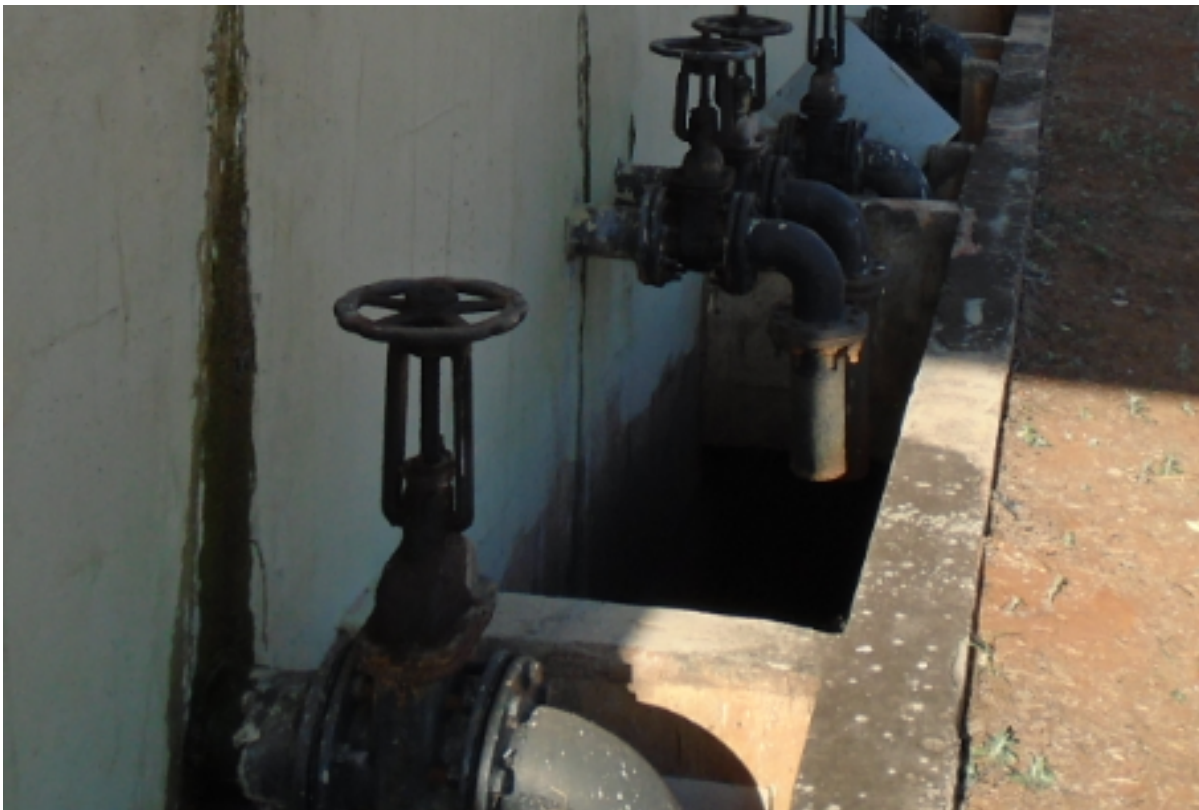
Figura 5 - Sistema de remoção do LETE dos reatores UASB.
