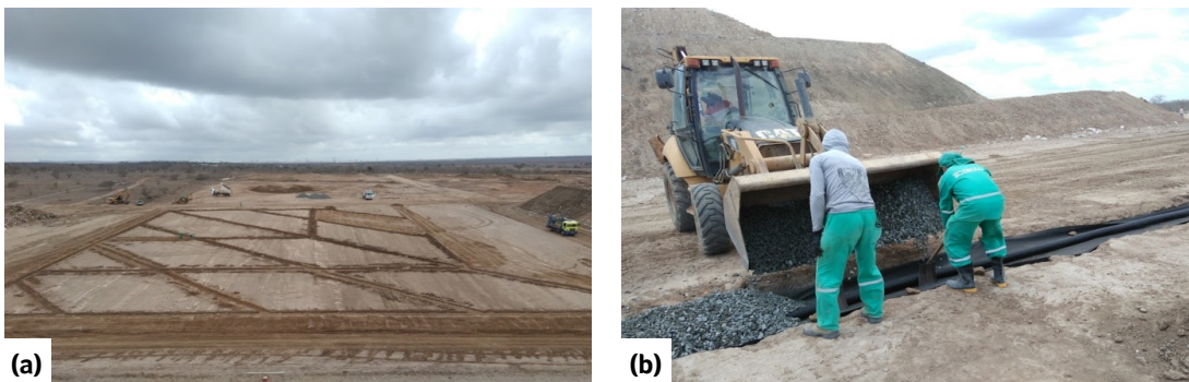
Figura 4 - Sistema de drenagem no Aterro Sanitário em Campina Grande: (a) disposição dos drenos, (b) abertura de valas com a adição de selo de bentonita, colocação de manta geotêxtil, tubulação e camada de brita Fonte: Acervo da pesquisa (2016)
