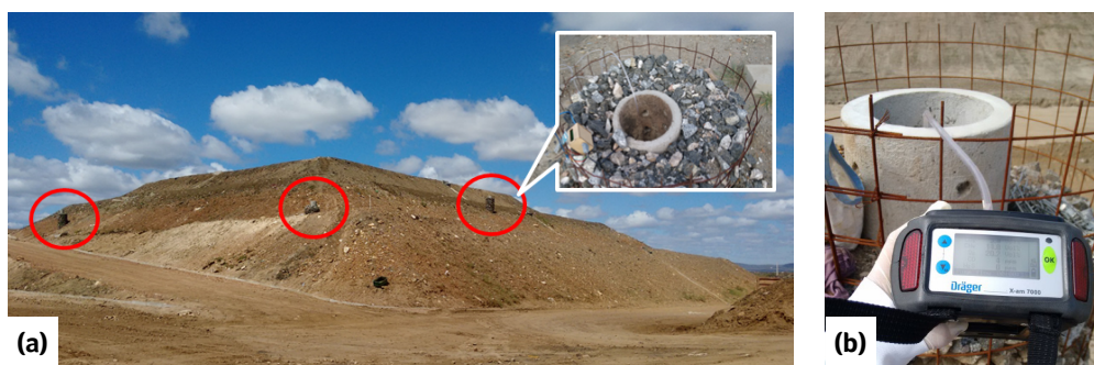
Figura 3 - Drenos verticais de gases no Aterro Sanitário em Campina Grande: (a) detalhe dos drenos e (b) medição de concentração dos gases
