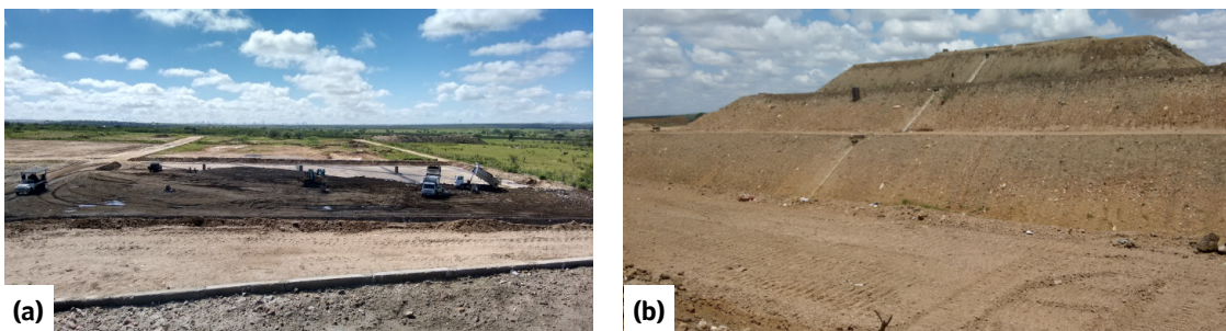
Figura 2 - Célula 2 do Aterro Sanitário em Campina Grande-PB: (a) início da operação, em dezembro de 2015 e (b) encerramento, em maio de 2016
