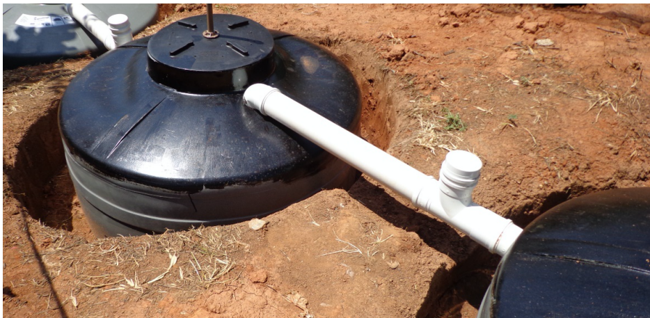
Figura 8 - Rebaixamento do solo para colocação das caixas d'água.
