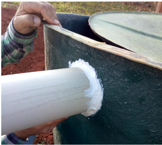
Figura 6 - Instalação de tubo de esgoto de 100 mm em caixa d'água.
