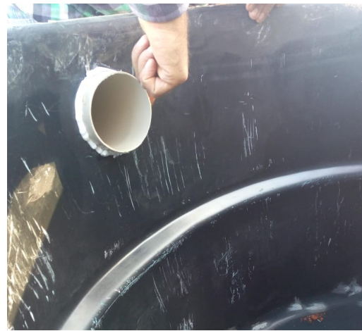
Figura 6 - Instalação de tubo de esgoto de 100 mm em caixa d'água.
