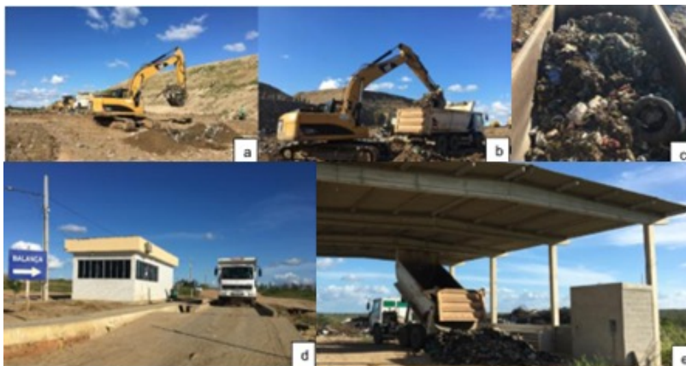
Figura 5 - (a) coleta da amostra dos resíduos; (b) acondicionamento dos resíduos no caminhão caçamba; (c) resíduos acondicionados; (d) pesagem dos resíduos; (e) disposição no galpão.
