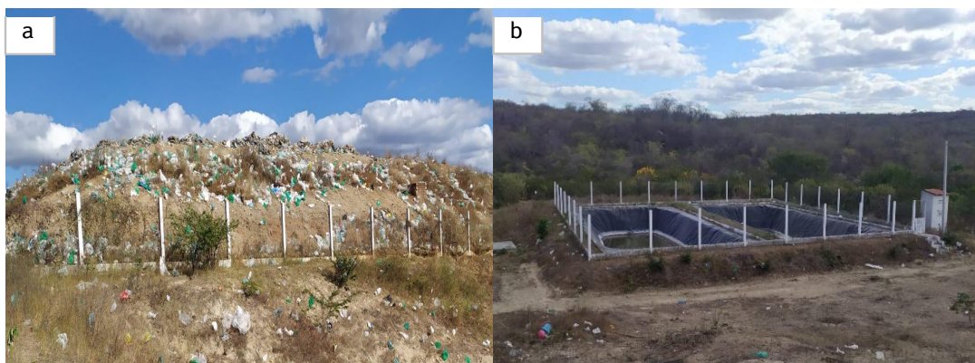
Figura 5 - Aterro Sanitário de Itaporanga/PB: (a) célula de resíduos e (b) lagoa de evapotranspiração do lixiviado Fonte: PMSB-PB/UFPG (2021).
