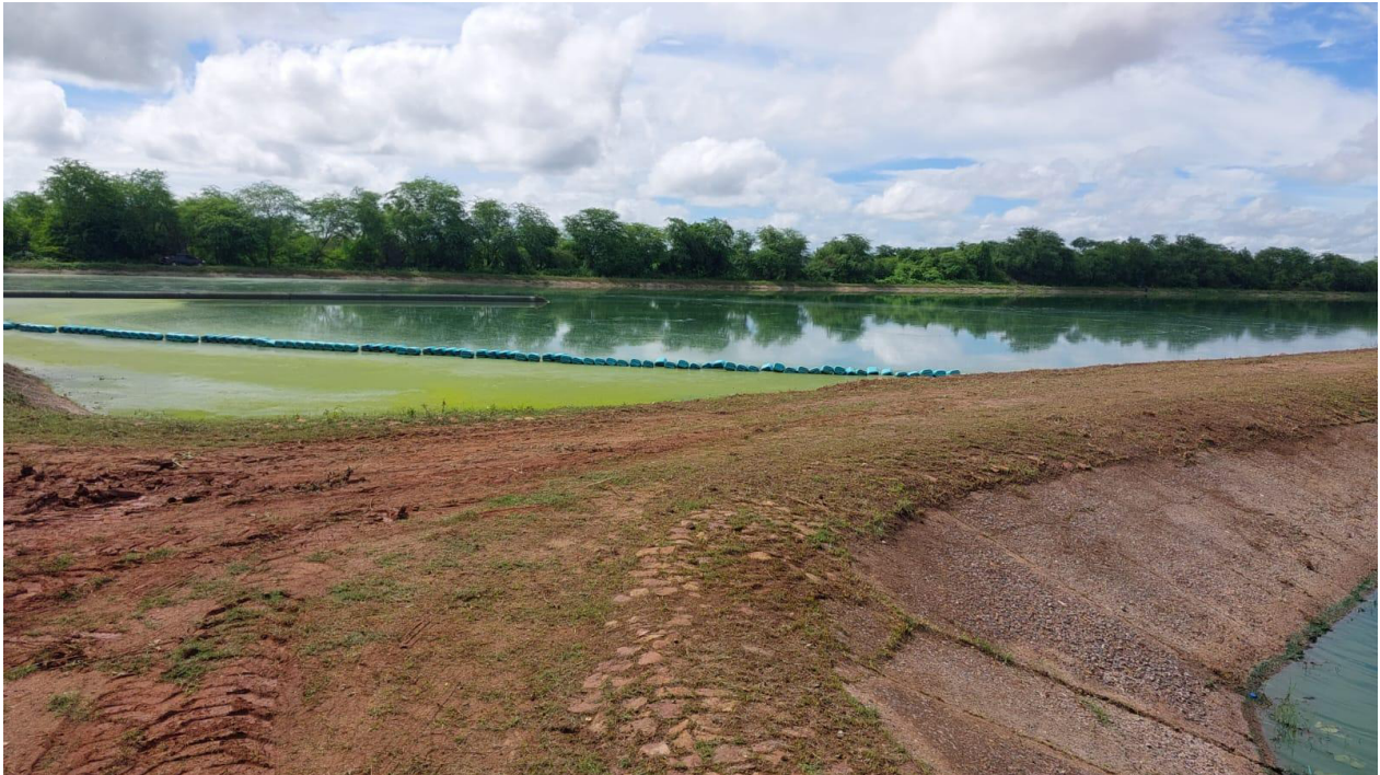
Figura 7 – Lagoa de Maturação do sistema ETE Malvas com contenção para algas.
