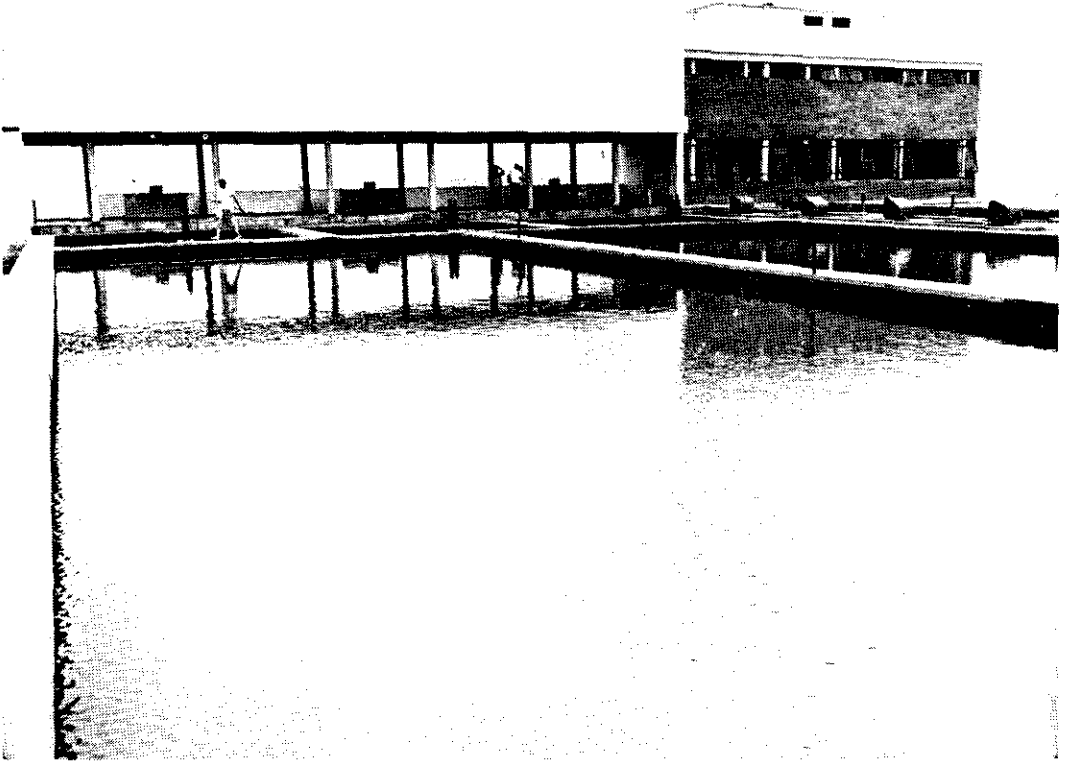
Estação de Tratamento de Água de Adamantina (30.000 habitantes) recentemente concluída com recursos da Caixa Econômica do Estado de S. Paulo.
