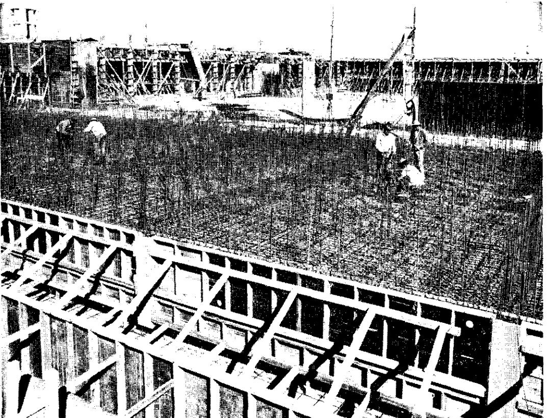
Construção da 3.ª Estação de Tratamento de Água de Campinas (400.000 habitantes).
