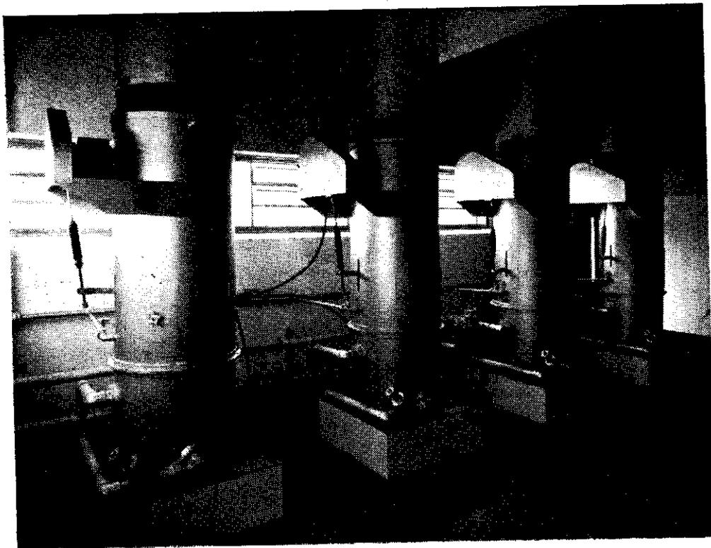
**Fig. 6 — Dosadores de sulfato e de cal de uma estação de tratamento moderna.**
