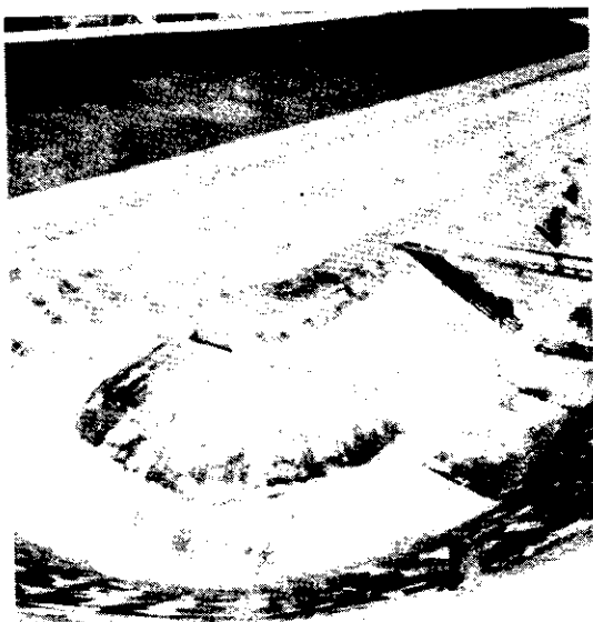
Foto 6 — Detalhe da curvatura no retorno dos esgotos pelo valo.
