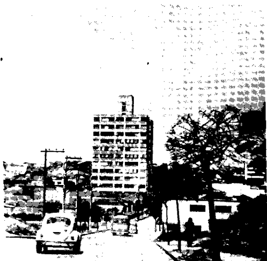
Foto 11 — Edifícios de 8 a 10 andares motivam densidades demográficas que alcançam 800 hab/hm 2 .
