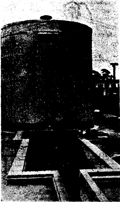
Jaçanan — Aéro-filtro e decantador secundario.
