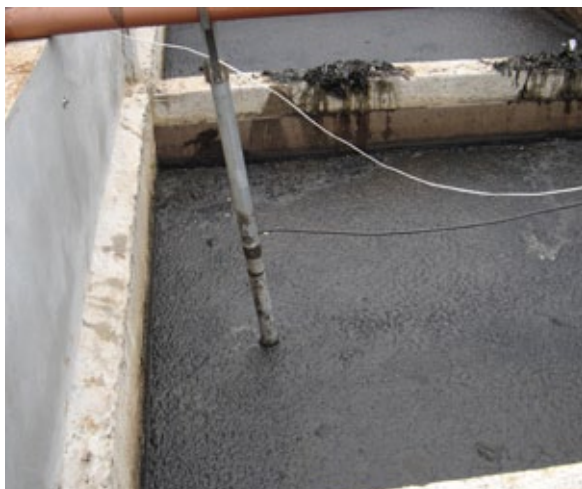
Figura 12 – Remoção do lodo dos tanques
