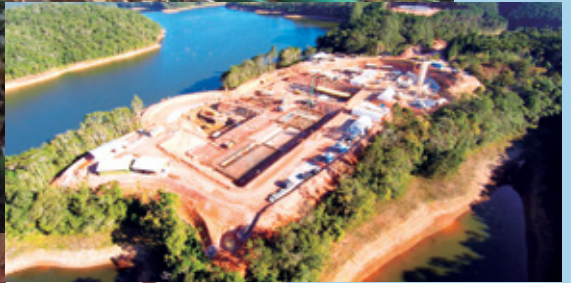
Sistema São Lourenço Maior obra de abastecimento em execução no país.
