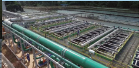
Ampliação da ETA Alto da Boa Vista Tecnologia de membranas ultrafiltrantes na ampliação do Sistema Guarapiranga.
