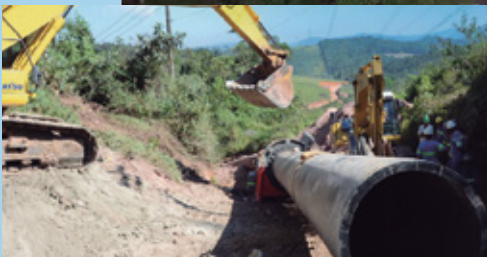
Interligação Rio Guaiú-Alto Tietê Redução da dependência do Sistema Cantareira.
