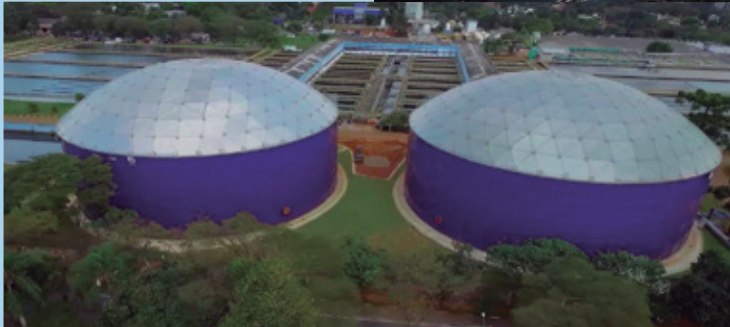
Reservatórios metálicos 20 reservatórios melhoram a distribuição de água.
