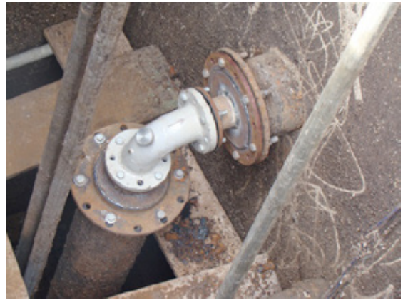
Figura 12 – A foto da esquerda mostra o poço de bombeamento da estação elevatória com o cotovelo já instalado. Observar a plataforma necessária para os trabalhos. A foto da direita mostra um detalhe do flange cego instalado na tomada de pressão durante a montagem.
