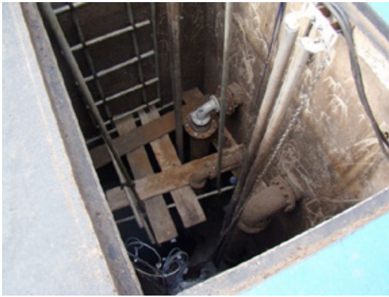
Figura 12 – A foto da esquerda mostra o poço de bombeamento da estação elevatória com o cotovelo já instalado. Observar a plataforma necessária para os trabalhos. A foto da direita mostra um detalhe do flange cego instalado na tomada de pressão durante a montagem.
