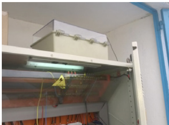
Figura 11 – A foto da esquerda mostra os sensores OEM desmontados e os dispositivos construídos para seu isolamento. Os sensores e a caixa de ligação (amarela) já estavam aparentemente isolados com silicone. A figura da esquerda mostra a caixa com o sistema de datalogger e baterias, encarregados da aquisição de sinais, colocada no gabinete elétrico das bombas.
