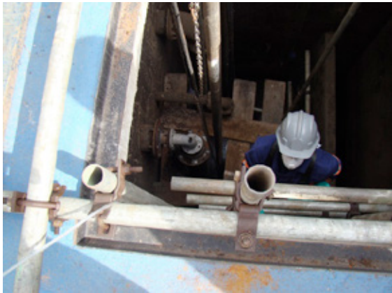
Figura 13 – A foto da esquerda mostra o cotovelo já sem o flange cego da tomada de pressão e a foto da direita mostra a instalação do sensor piezorresistivo.
