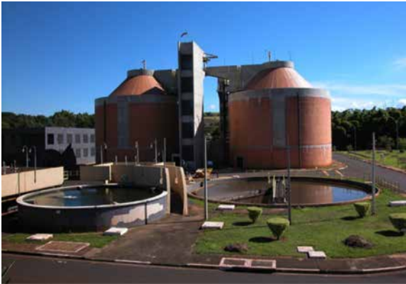
Figura 1: Digestores anaeróbios da ETE Franca – São Paulo sem sistema de aquecimento e temperatura média de 23°C
