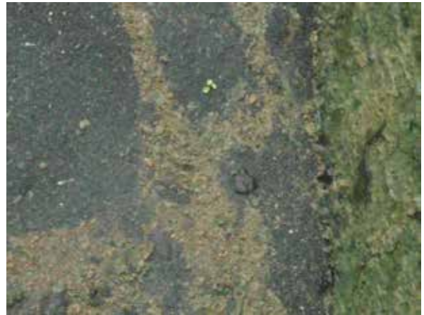
Figura 4: Vegetação na superfície do leito de areia e paredes do filtro.
