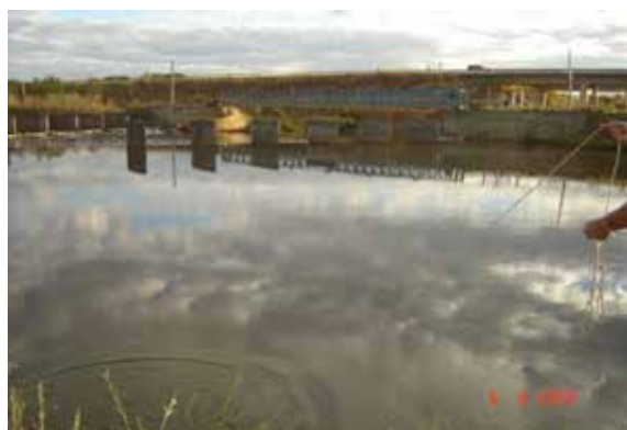
Lago a montante da barragem de elevação de nível (2005)
