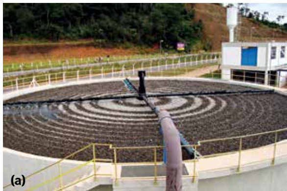
Figura 5 – a) Má distribuição do efluente no topo de filtro biológico percolador pós-reatores UASB; b) colmatação do leito de pedras por elevação da carga de sólidos.
