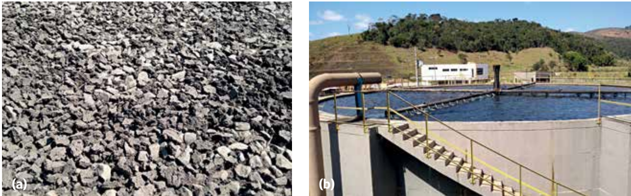
Figura 1 – Impacto da perda excessiva de sólidos sobre a unidade de pós-tratamento: a) colmatação do meio suporte; b) afogamento de filtros biológicos percoladores pós-reatores UASB.
