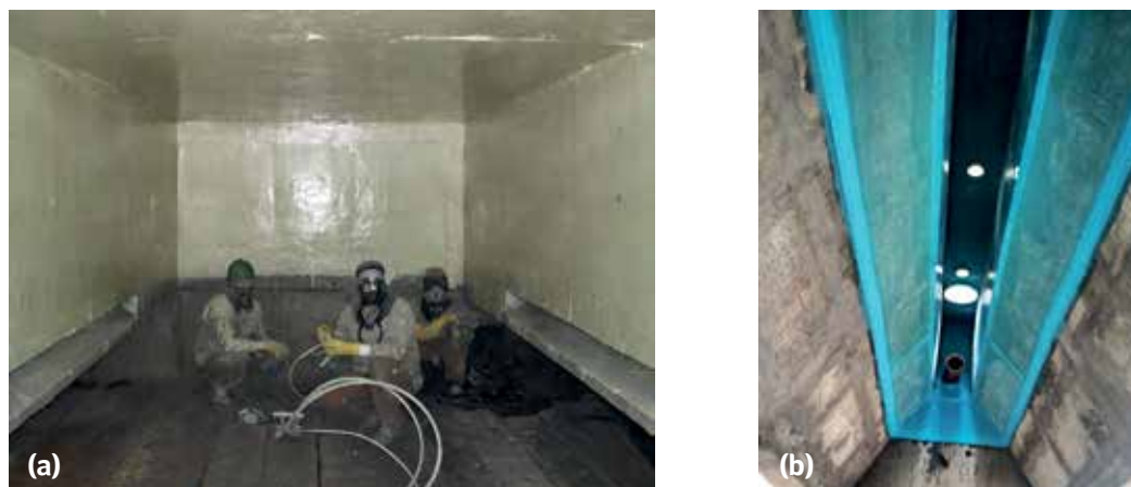
Figura 9 – Revestimento interno de reatores UASB: a) aplicação de Polibrid; b) aplicação de PRFV.
