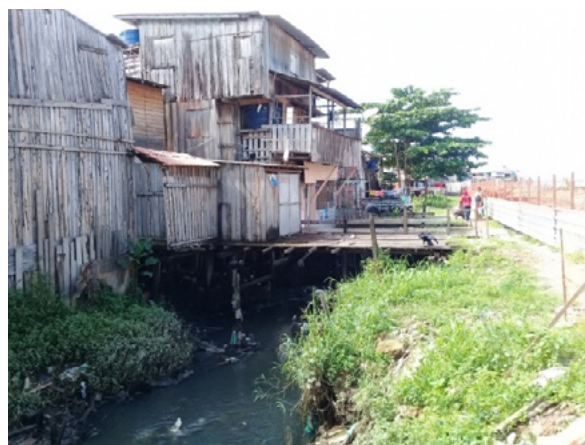
Figura 4 Condições habitacionais de algumas residências localizadas na av. Bernardo Sayão.
